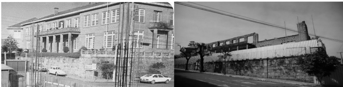
Figura 3: Prédio Eunice Andrew, imagem de 1970 ainda íntegro e imagem de 2016 em ruínas após incêndio, que foram demolidas em 2018.
