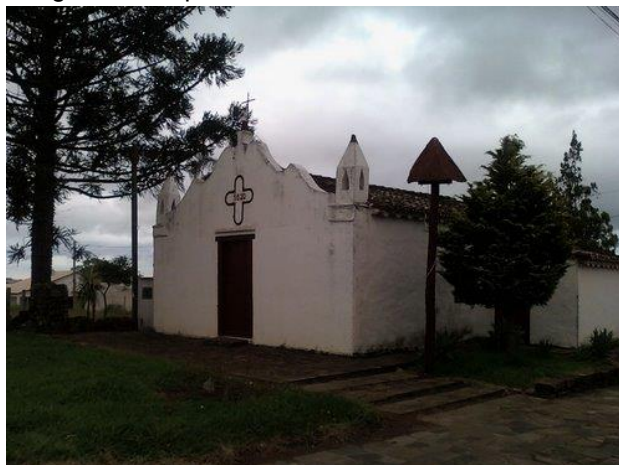
Figura 2 - Capela Nossa Senhora dos Remédios
