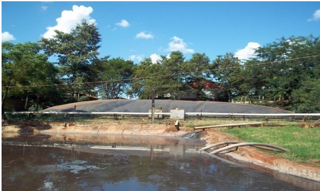
Figura 08 - Tanques de captação de dejetos e formação de biogás Fonte: Granja Gerhardt
