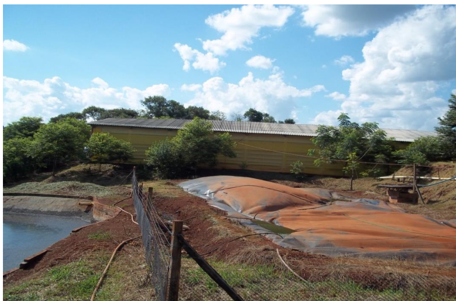
Figura 09 - Tanques de formação de biogás Fonte: Granja Gerhardt
