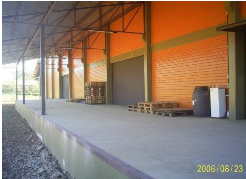
Figura 11 - Plataforma de descarga
