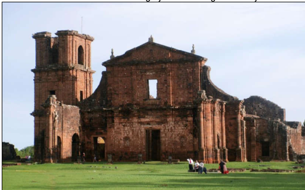
FIGURA 7 – Ruínas da Igreja de São Miguel Arcanjo.
